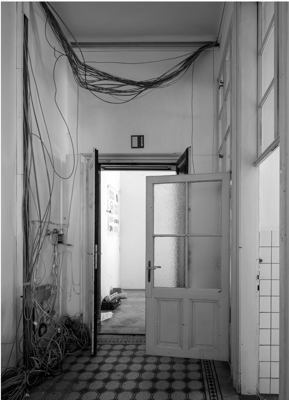
Kabelwerk im ehemaligen Bürotrakt. Foto: Kollektiv Fischka/Kramar
