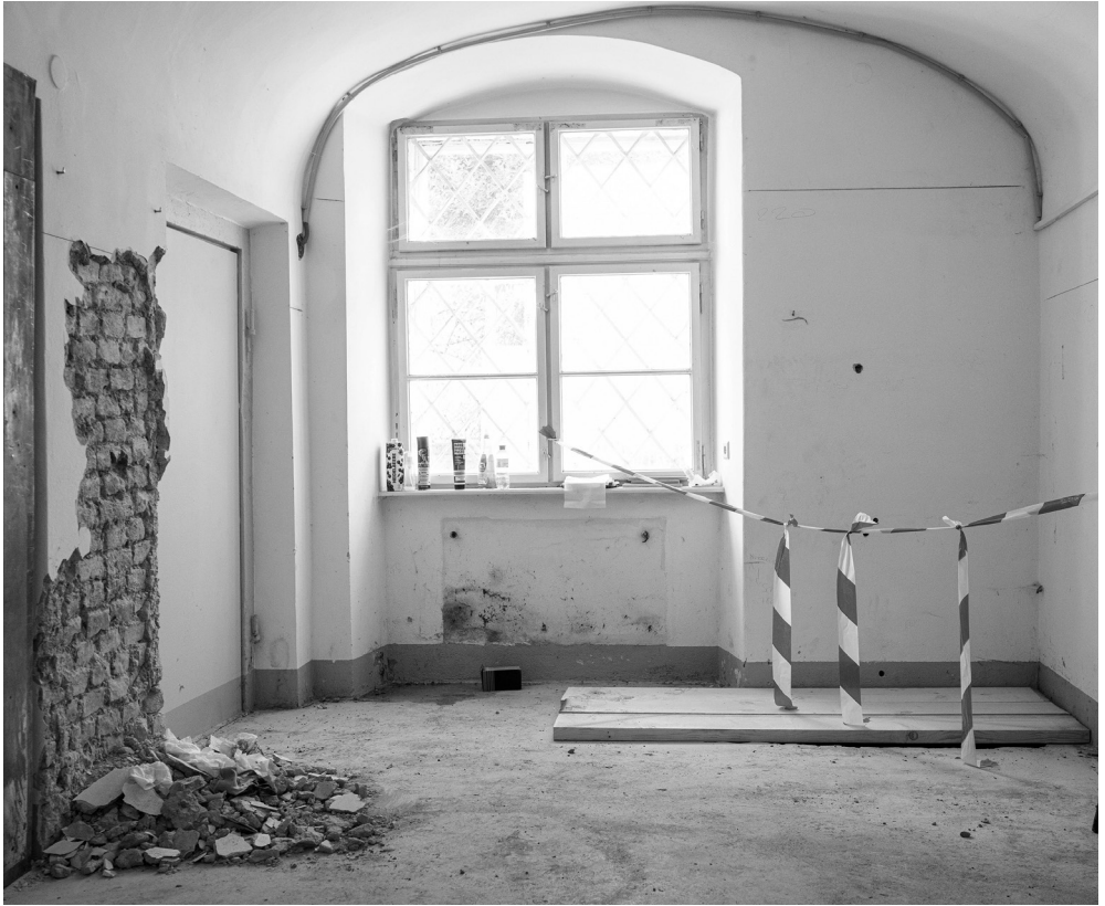
Seiteneingang in den Pavillon 1 am OWA. Foto: Kollektiv Fischka/Kramar
