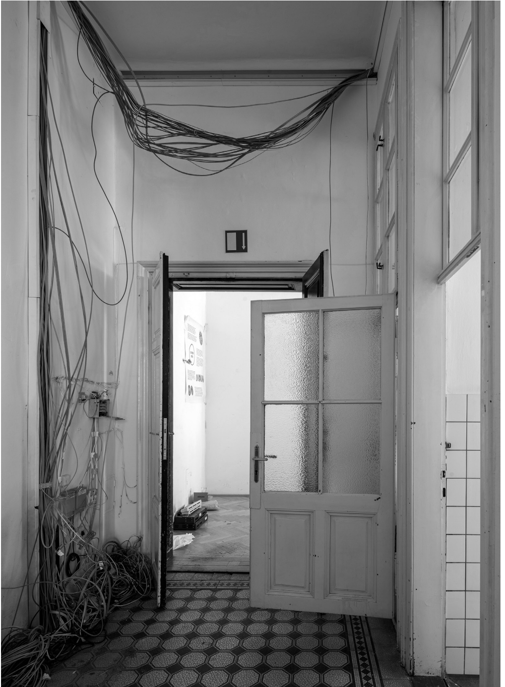
Kabelwerk im ehemaligen Bürotrakt. Foto: Kollektiv Fischka/Kramar
